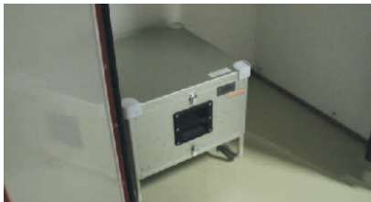
ボルトで固定されているブース内のラップボン
